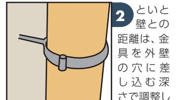
2 といと壁との距離は、金具を外壁の穴に差し込む深さで調整して、他の金具の設置部分にそろえます。最後に金具を縦どいに固定したら完了です。
